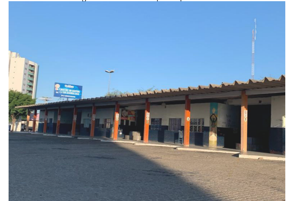
Figura 66: Edifício do antigo terminal rodoviário da cidade, atualmente utilizado para funções institucionais. Fonte: Autor
