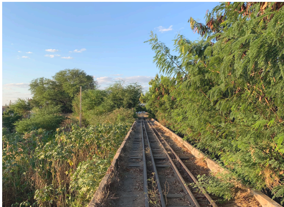
Figura 70: Ponte sobre o Rio Espinharas, destinada à passagem do trem. Atualmente serve informalmente para passagem de pedestre entre o Centro e o Beiral. Fonte: Autor
