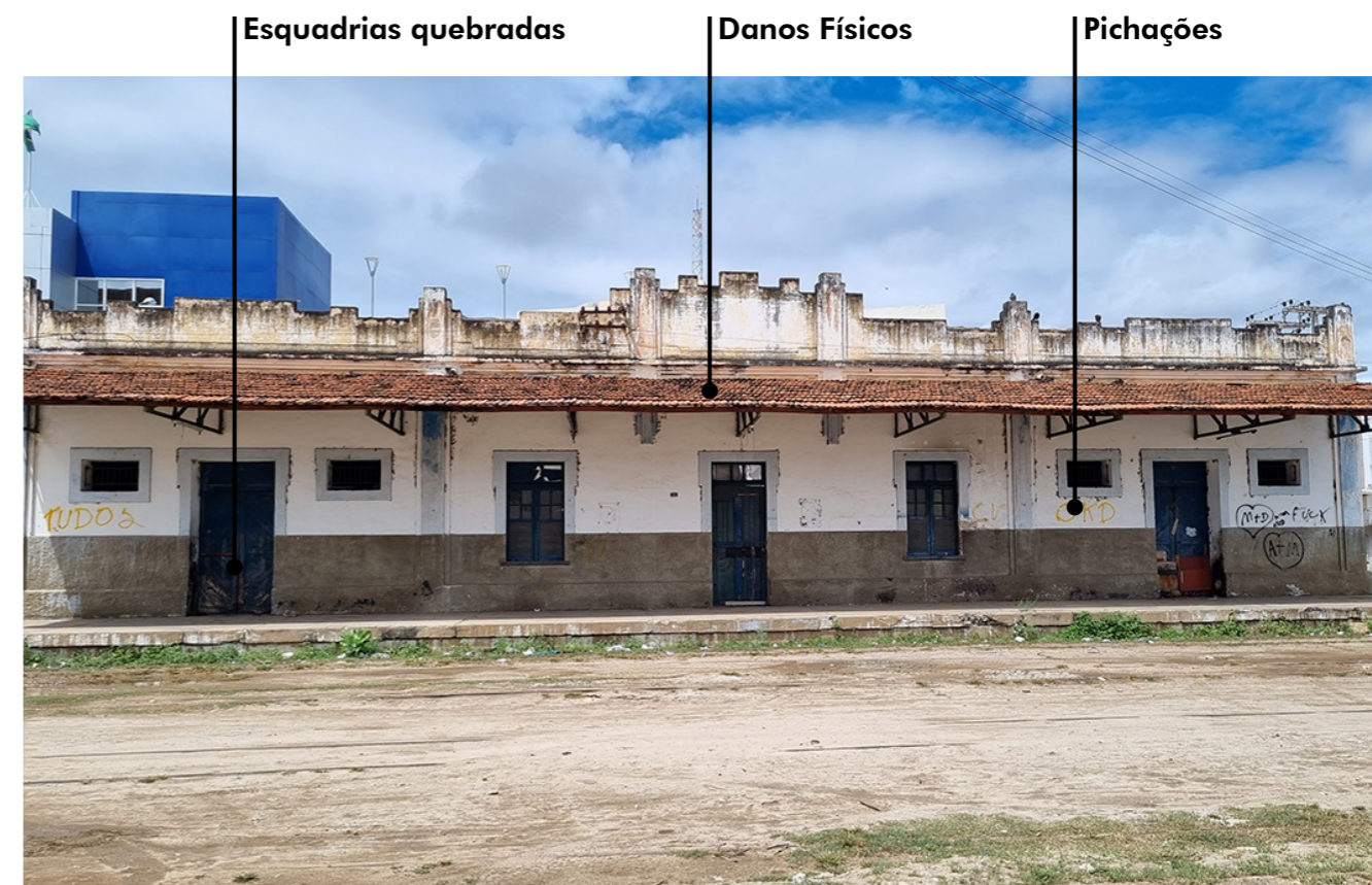
Figura 85: Vista frontal da Estação ferroviária a partir do seu largo. Fonte: Rhuan (2022)
