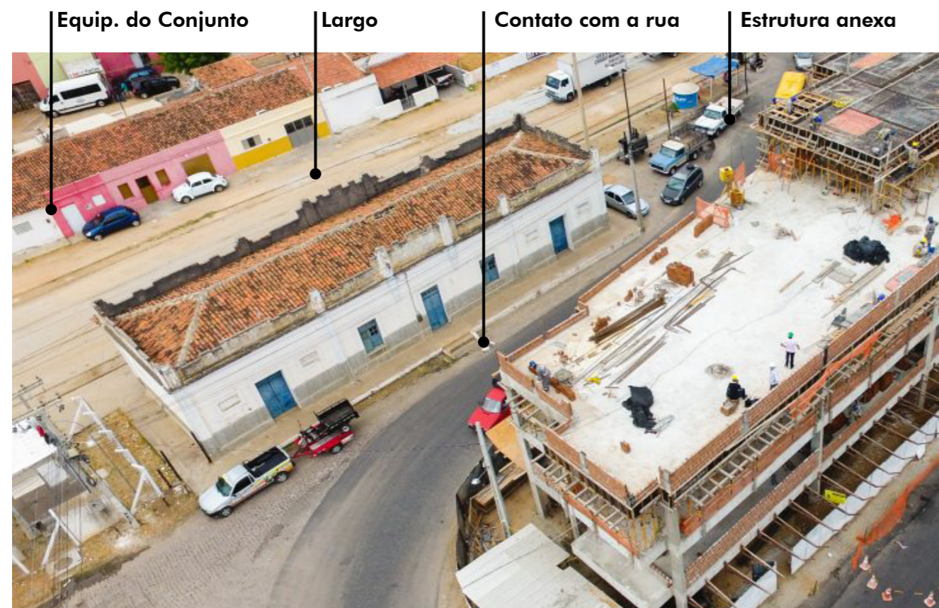
Figura 84: Estação ferroviária e seu entorno vistos de cima. No lado direito é possível ver o edifício do SENAC, ainda em construção, já no canto superior esquerdo, vê-se as residências da Vila Ferroviária. Fonte: Planes Engenharia (2017)
