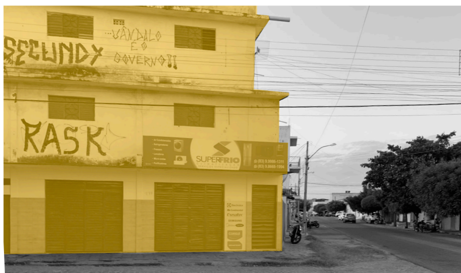
Figura 47: Edificação do Tipo II, neste caso, edifício de 3 pavimentos na comunidade Beiral. Fonte: Autor
