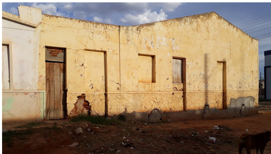
Figura 21: Edificação lindeira à linha férrea localizada na região do “Baixo Meretrício” Fonte: Folha Patoense (2018)
