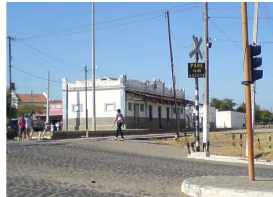
Figura 32: Estação Ferroviária de Patos em 2007, num estado de conservação melhor que o atual. Fonte: Autor
