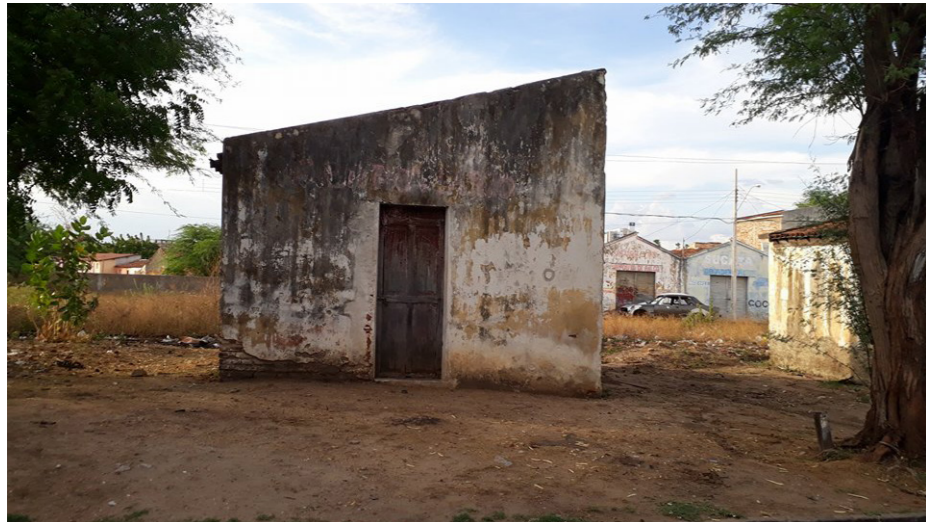
Figura 20: Edificação lindeira à linha férrea localizada na região do “Baixo Meretrício” Fonte: Folha Patoense (2018)
