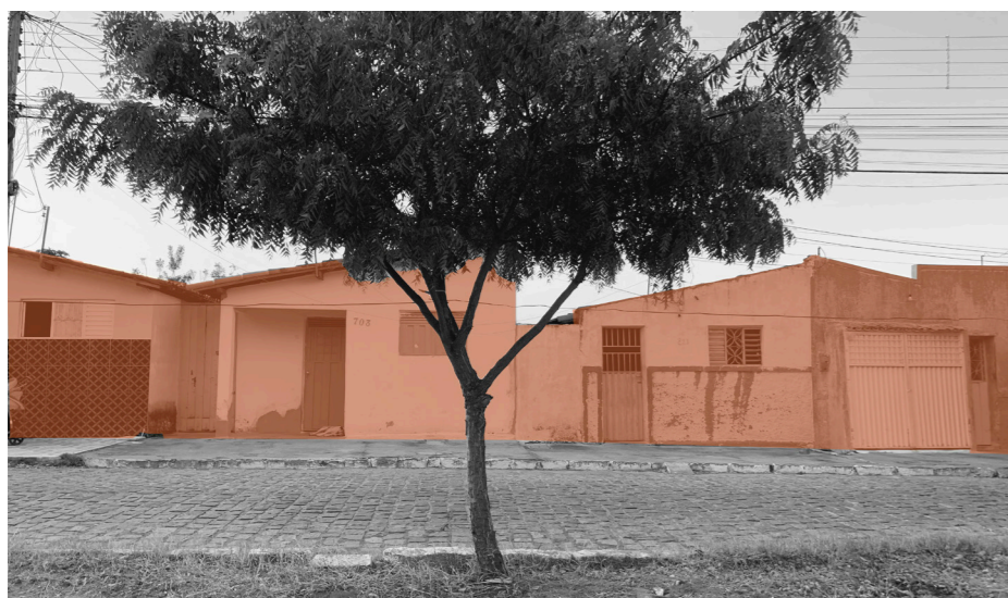
Figura 46: Edificações do Tipo I, neste caso, residências da comunidade Beiral. Fonte: Autor
