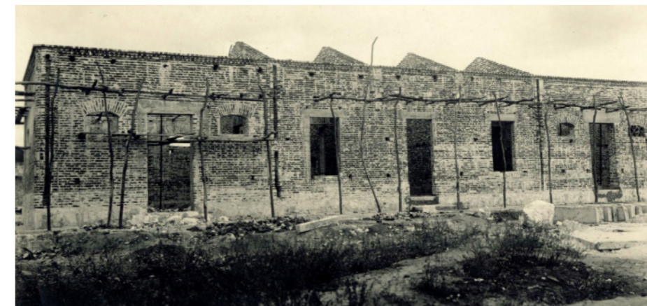
Figura 27: Estação Ferroviária de Patos em construção, no ano de 1928. Fonte: Acervo da Rede de Viação Cearense apud Farias et al., (2021)
